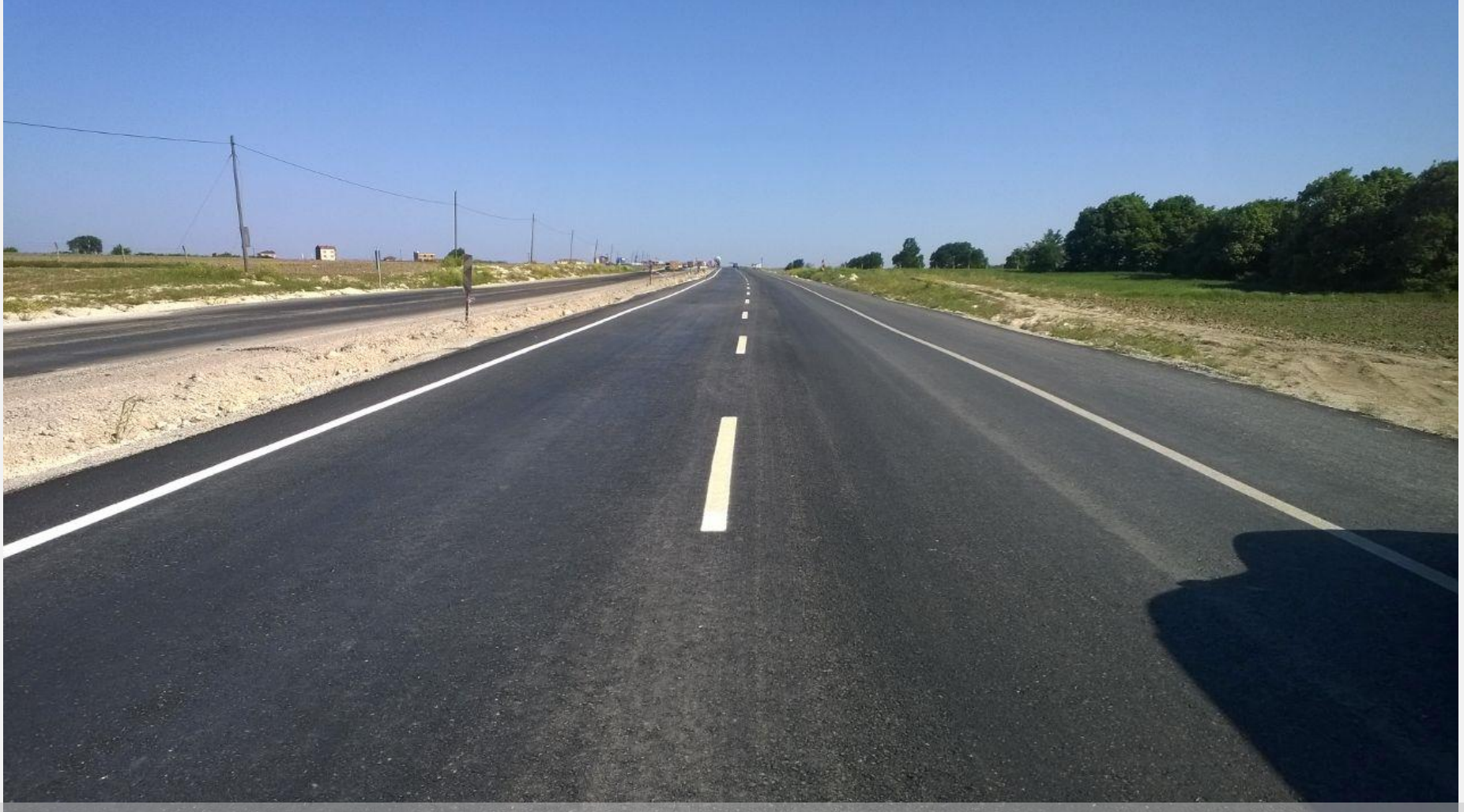
NovoCrete® tabakası üzerine asfalt ve şerit çalışması sonrası (12.05.2015)
