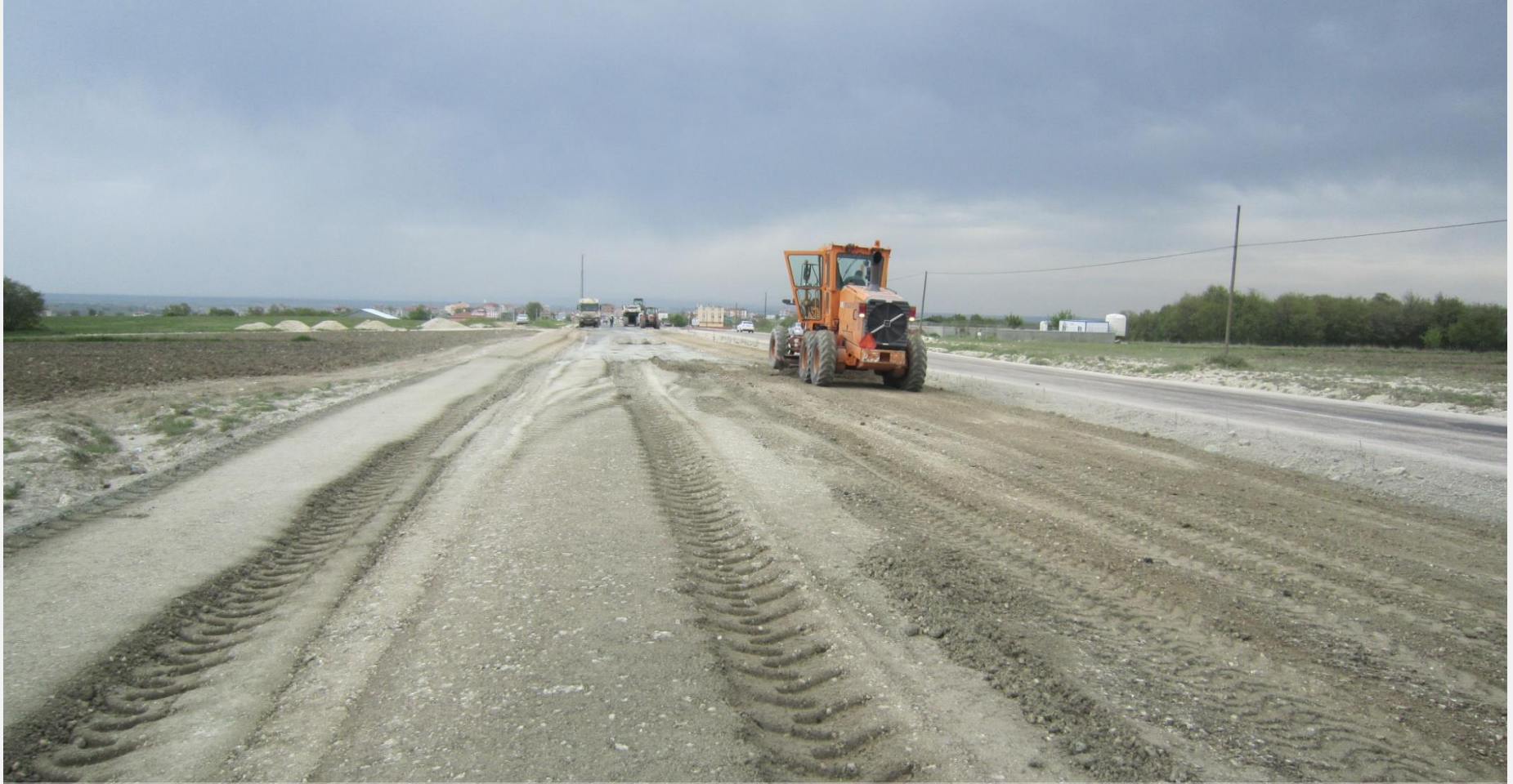
Greyder aracılığı ile NovoCrete® tabakasının düzleştirilmesi (29.04.2015)
