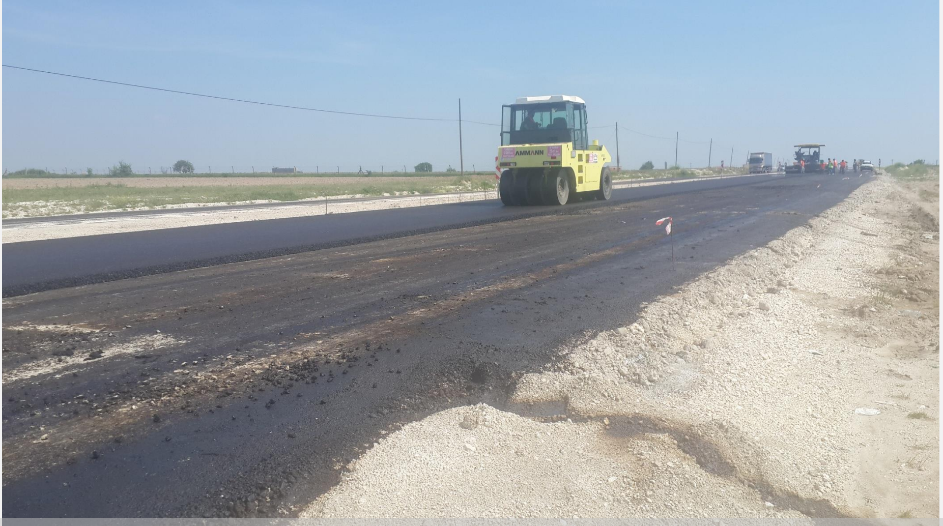
NovoCrete® tabakası üzerine astar+binder çalışması (05.05.2015)
