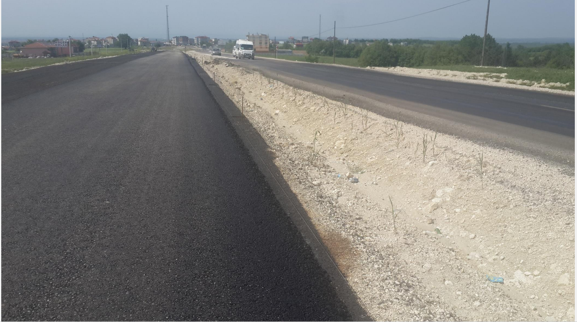
NovoCrete® tabakası üzerine astar+binder çalışması (05.05.2015)
