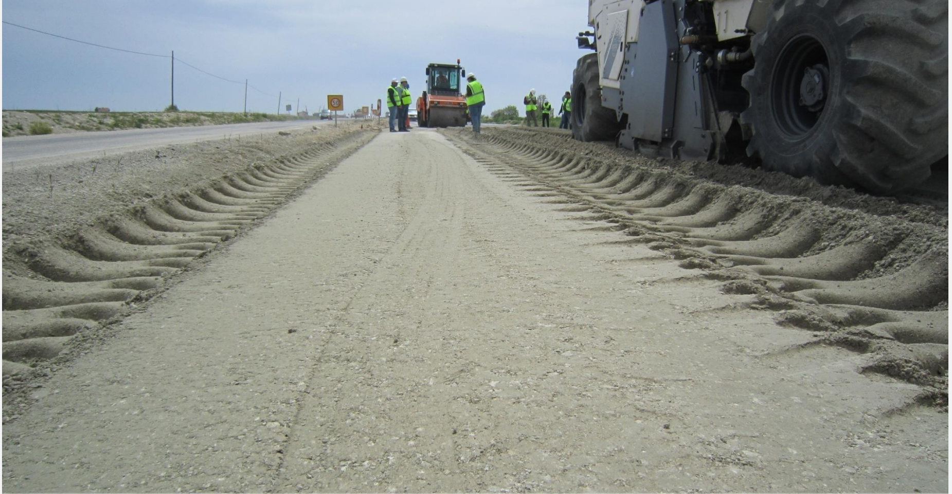
Dinamik olarak düz silindir ile tekerlek arası kot farkını düzeltme işlemi (28.04.2015)
