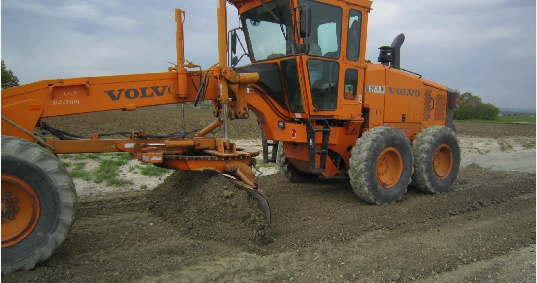
Greyder aracılığı ile NovoCrete® tabakasının düzleştirilmesi (28.04.2015)
