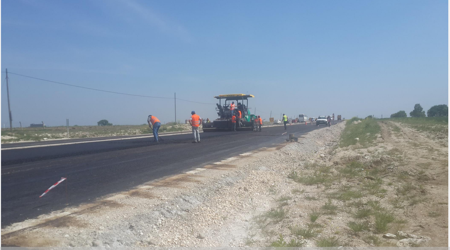
NovoCrete® tabakası üzerine astar+binder çalışması (05.05.2015)
