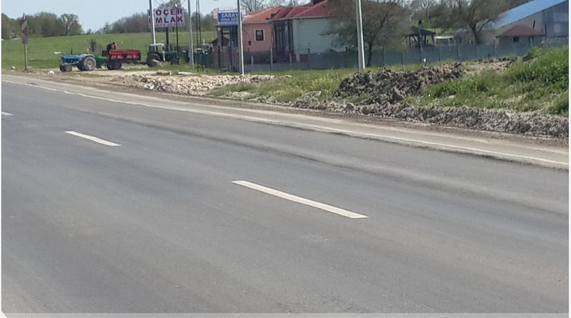
NovoCrete® Uygulama öncesi yolun durumu (20.04.2015)
