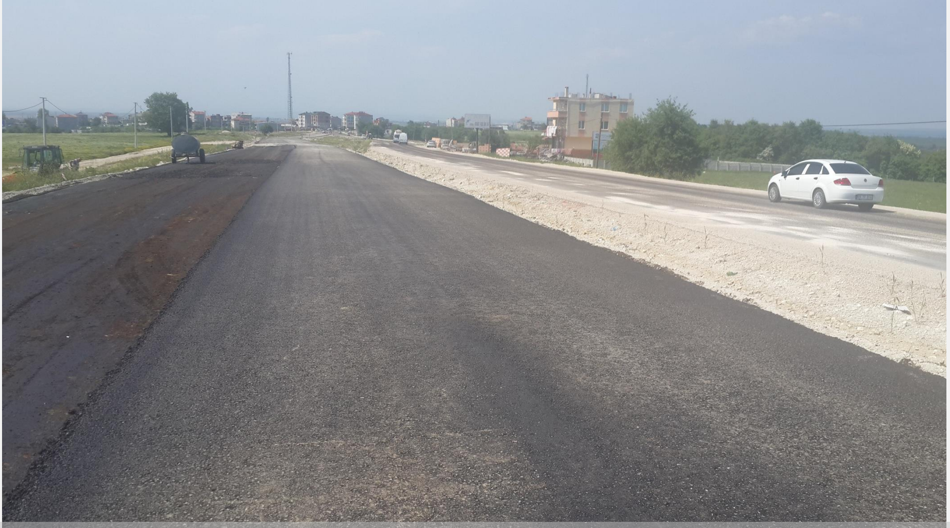
NovoCrete® tabakası üzerine astar+binder çalışması (05.05.2015)
