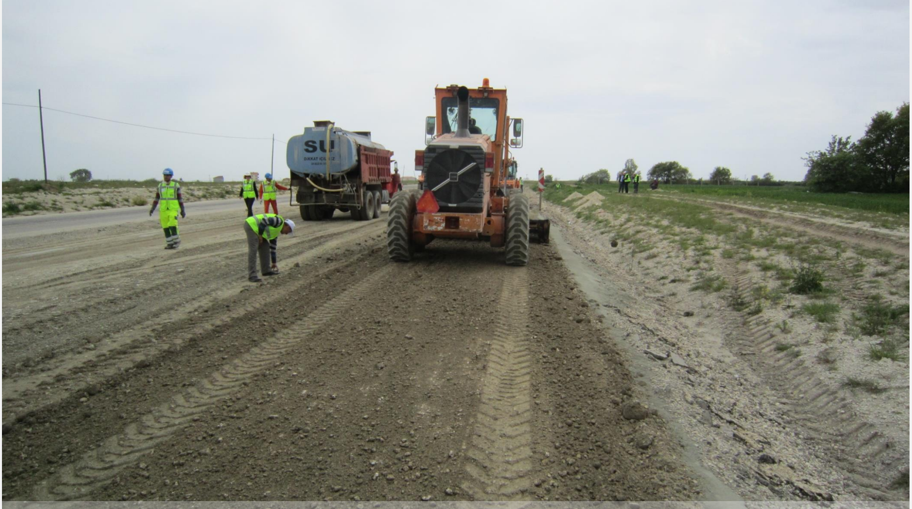
Greyder aracılığı ile NovoCrete® tabakasının düzleştirilmesi (28.04.2015)
