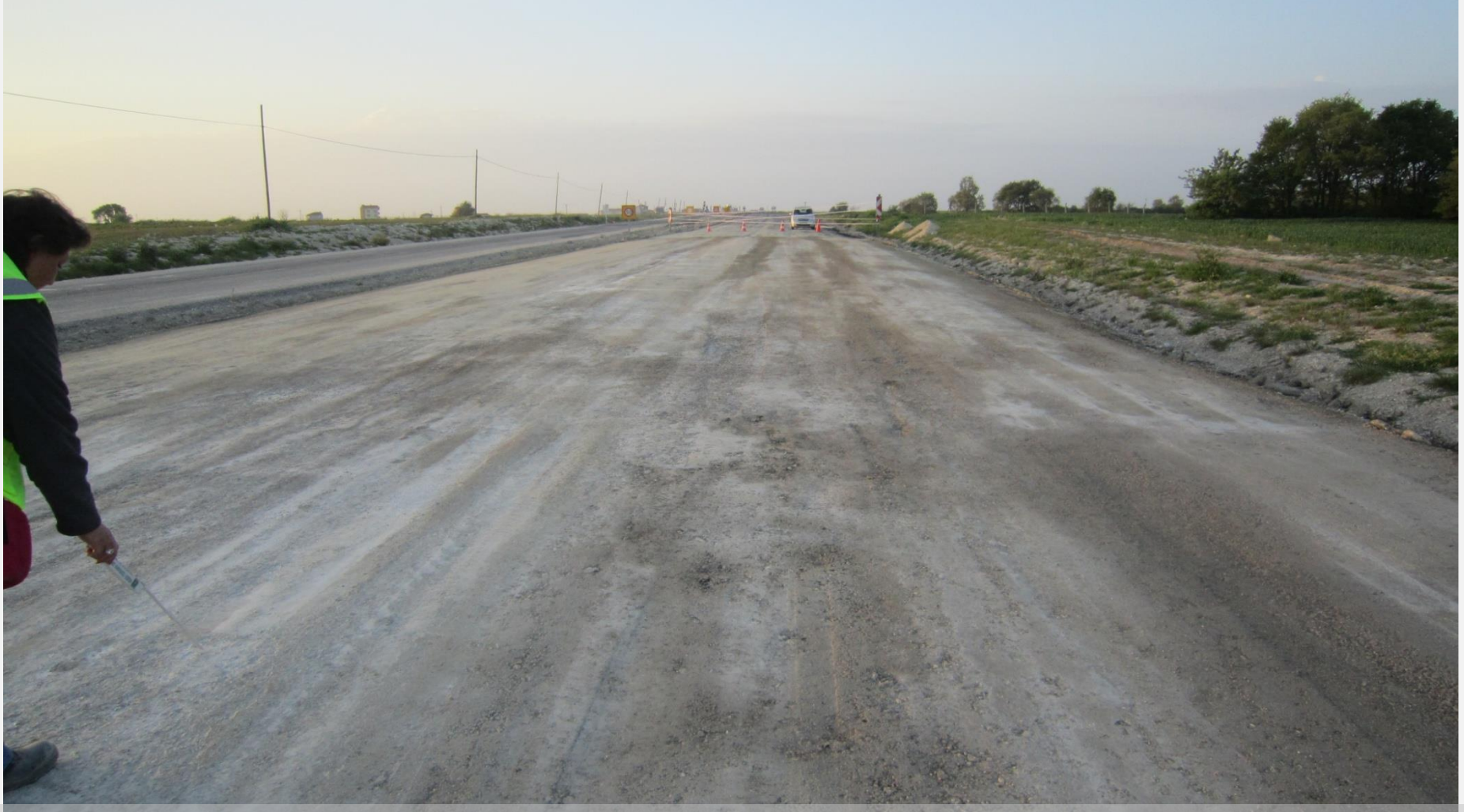
Sıkıştırmadan sonrası NovoCrete® tabakasının yüzeyi (29.04.2015)
