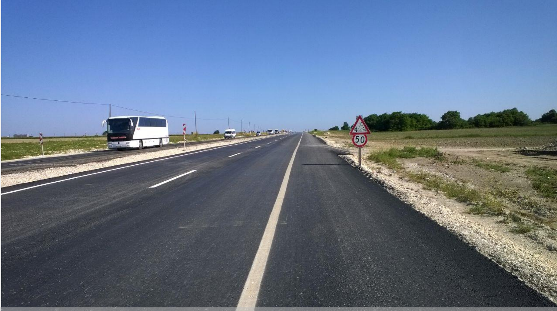
NovoCrete® tabakası üzerine asfalt ve şerit çalışması sonrası (11.05.2015)
