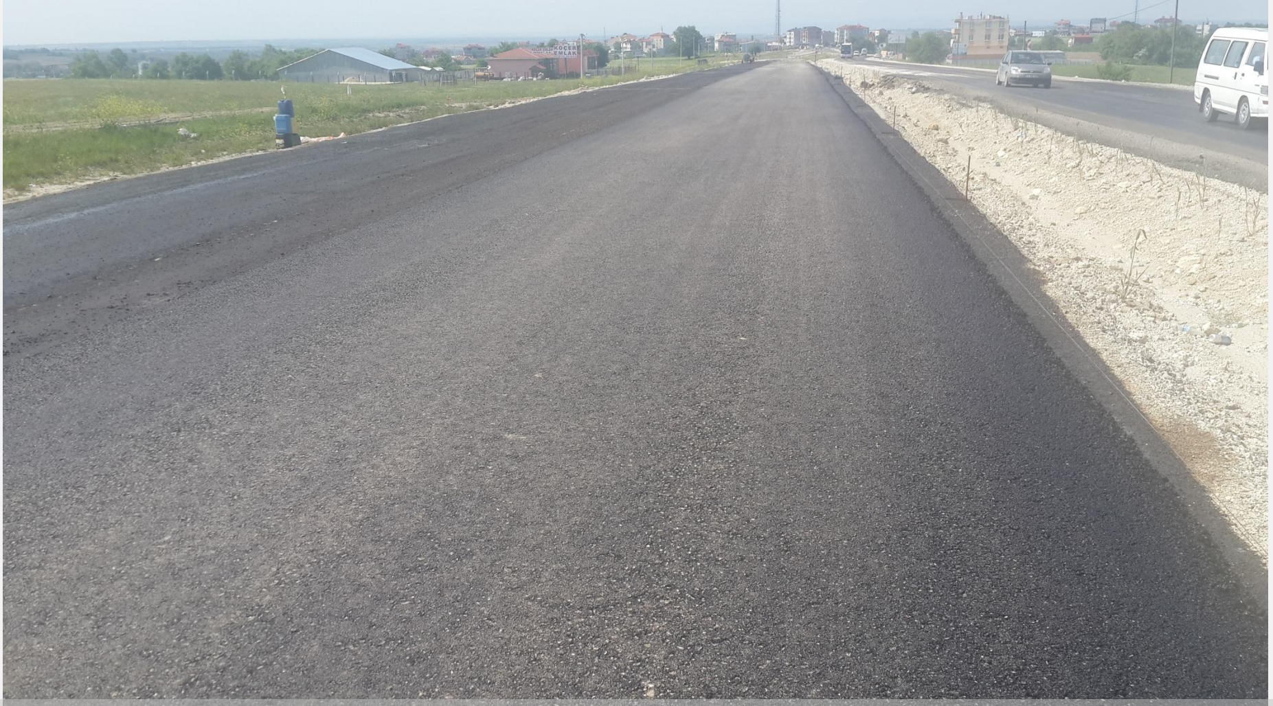
NovoCrete® tabakası üzerine astar+binder çalışması (05.05.2015)
