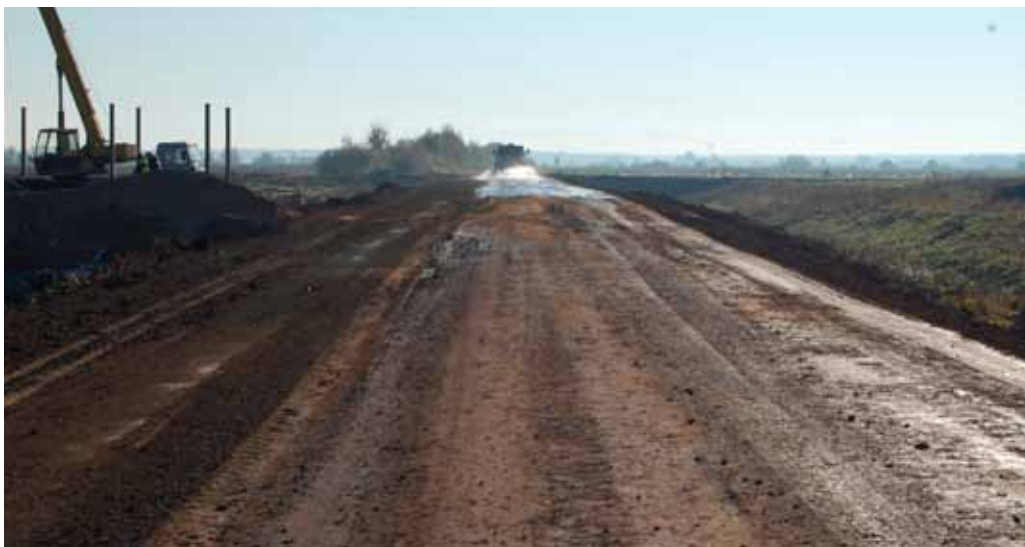
Непрерывное увлажнение поверхности
