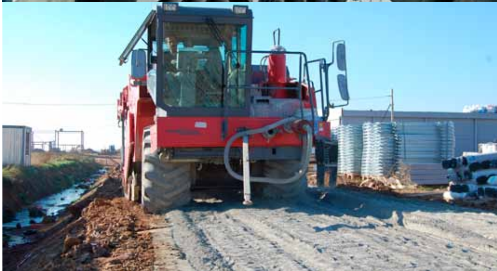
Фрезерование грунта со связующим веществом на глубине до 0,45 м
