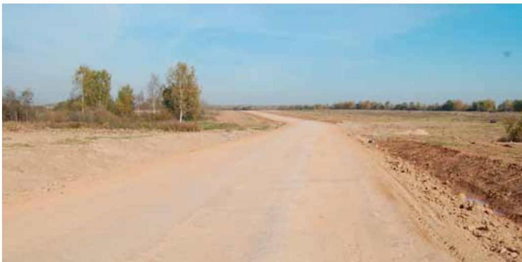
Глинистая дорога после завершения строительных работ
