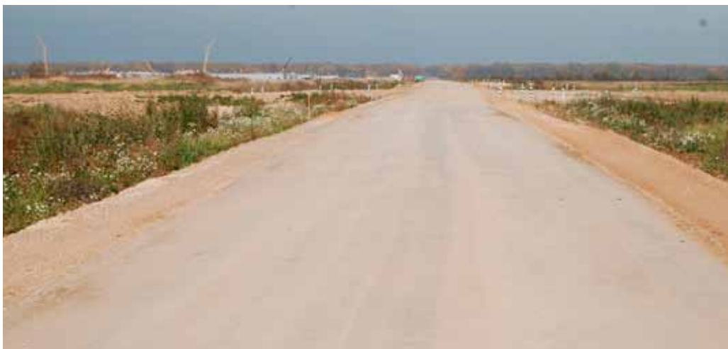
Щебеночный участок после проведения строительных работ
