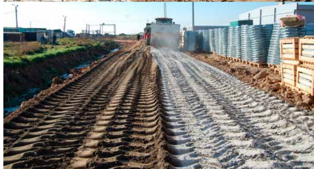
Распределение аддитива к цементу NovoCrete® по поверхности грунта
