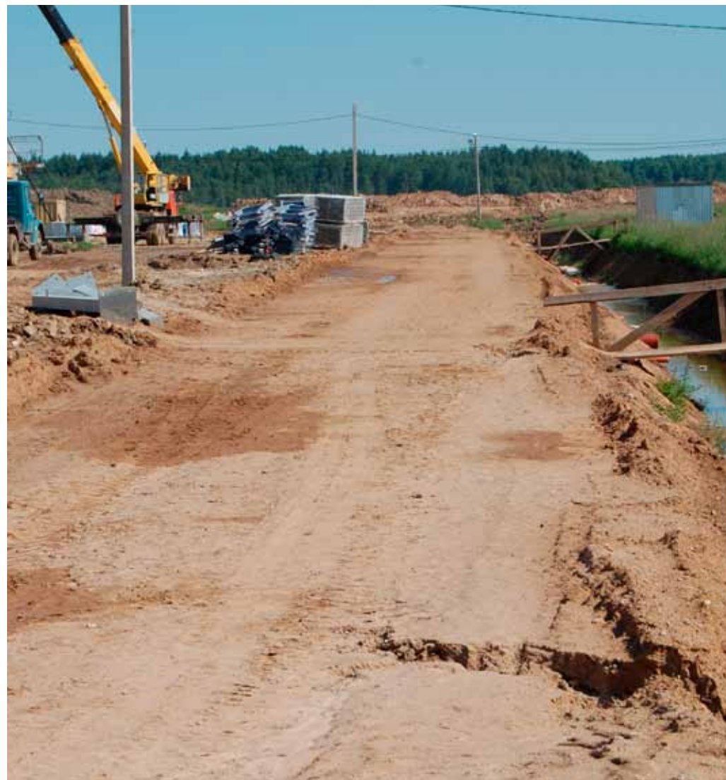
Исходный вид полотна до отсыпки глиняной насыпи
