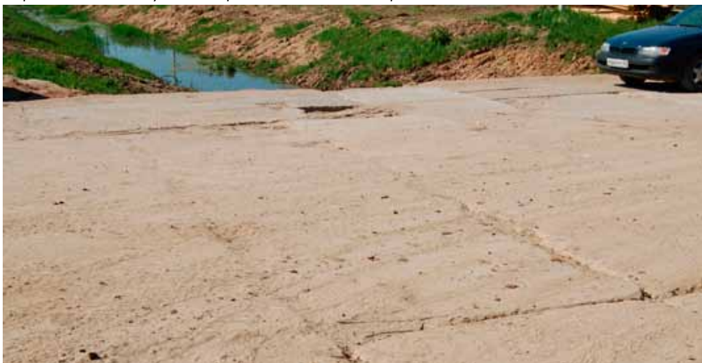
Прежнее дорожное полотно состояло из проложенных бетонных плит
