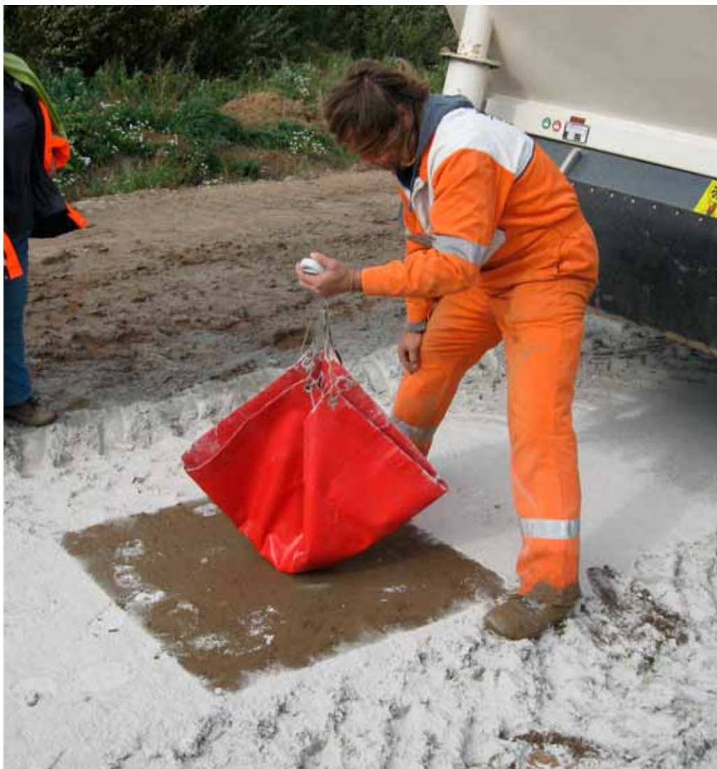
Контроль количества рассыпанного по поверхности грунта аддитива NovoCrete®
