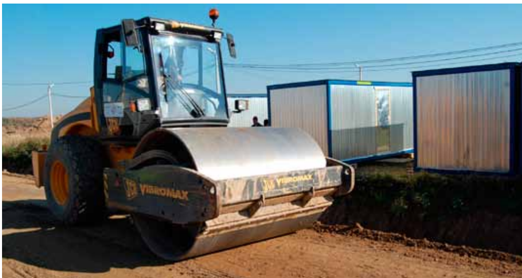
Вибрационное и статическое уплотнение грунта гладковальцевым катком (вес катка -12 тонн)
