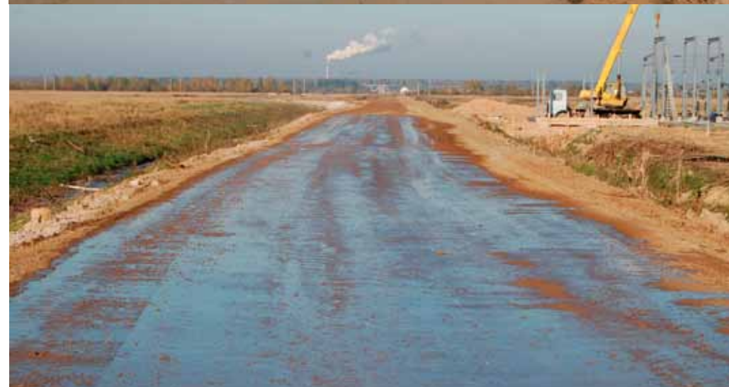
Дополнительное увлажнение поверхности для защиты полотна от чрезмерного высыхания
