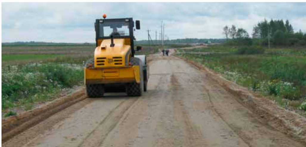
Работа катка по уплотнению основания
