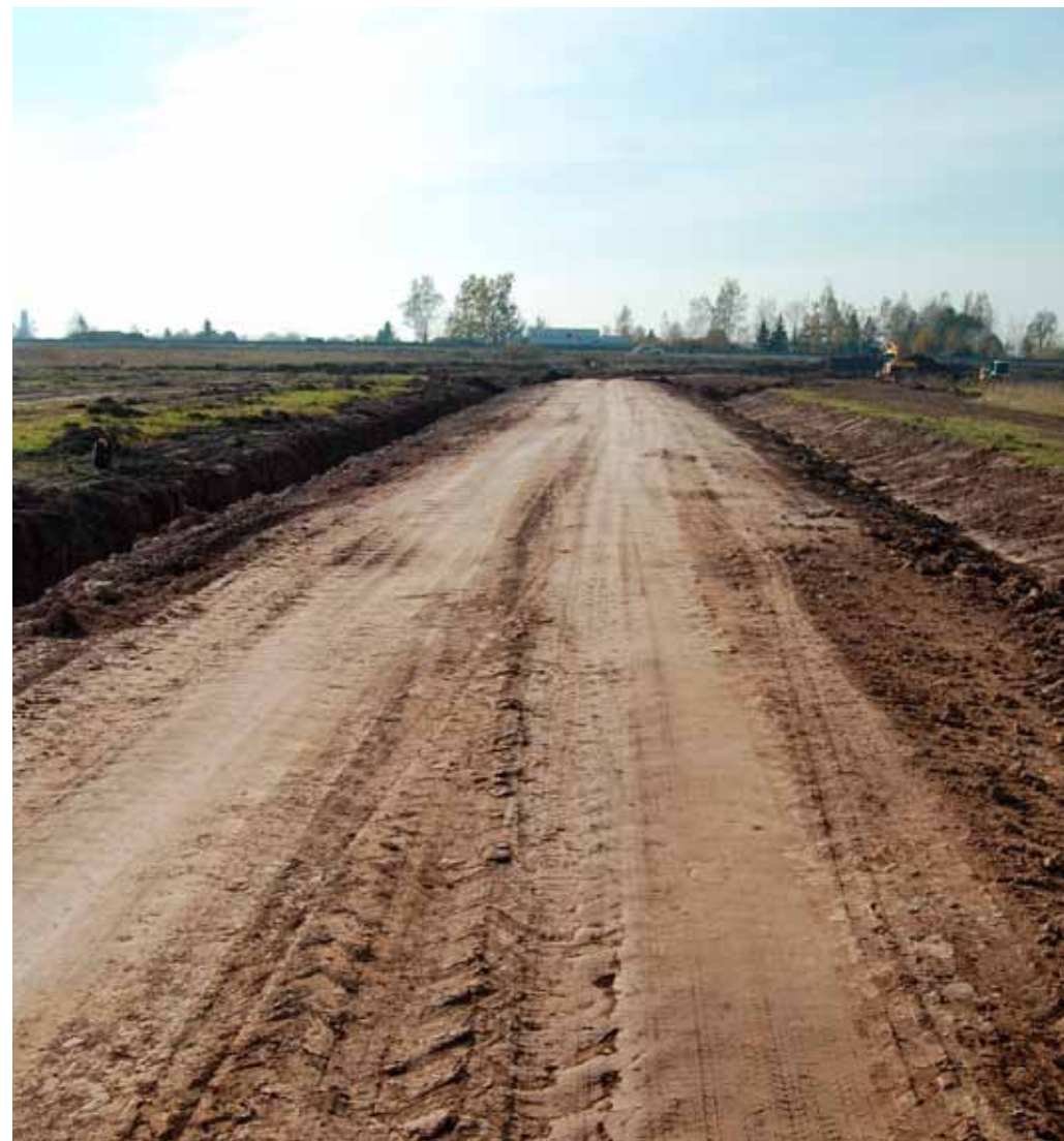
Подготовительные работы на участке подвязки дороги к автобану
