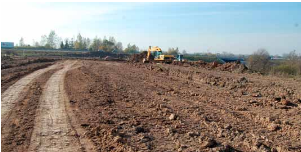
Подготовительные работы по прокладыванию линии прохождения трассы
