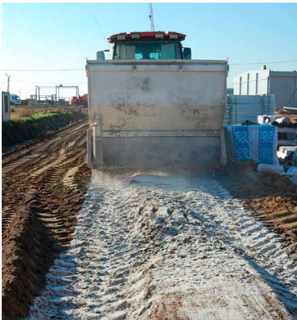
Трактор с прицепным распределителем добавки к цементу NovoCrete®
