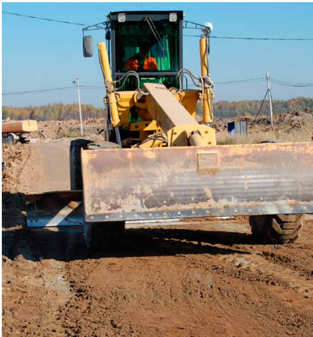
Работа грейдера по созданию точно выровненной поверхности полотна
