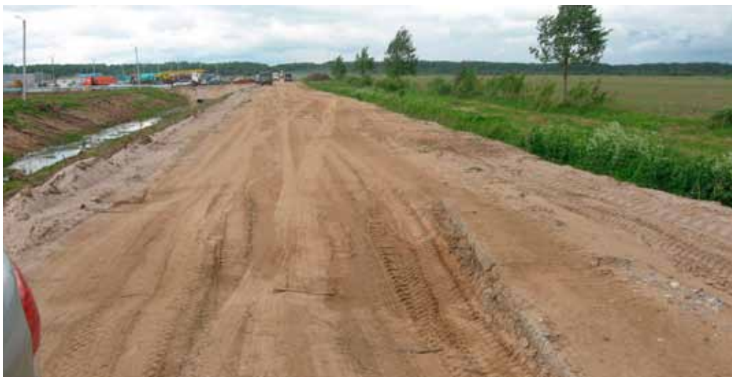
Первоначальный вид полотна: состояние дороги до начала стабилизационных работ
