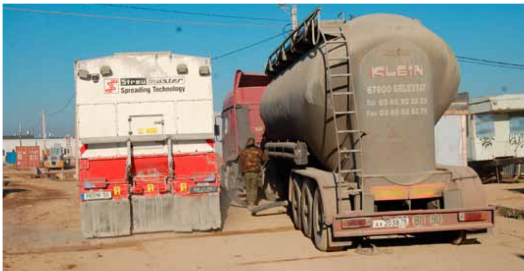
Загрузка распределителя цементом
