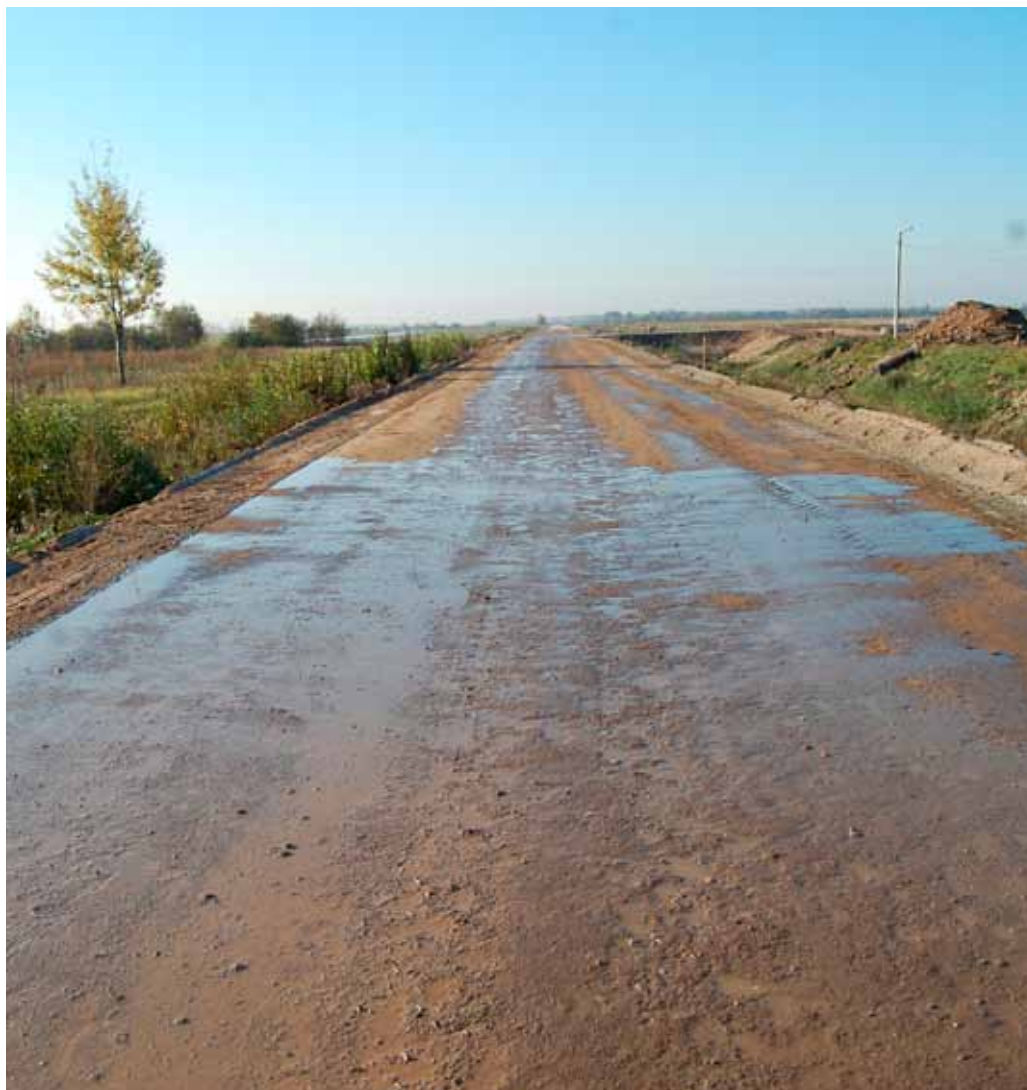
Поверхность полотна на перекрестке щебеночного и глинистого участков дороги после ее увлажнения
