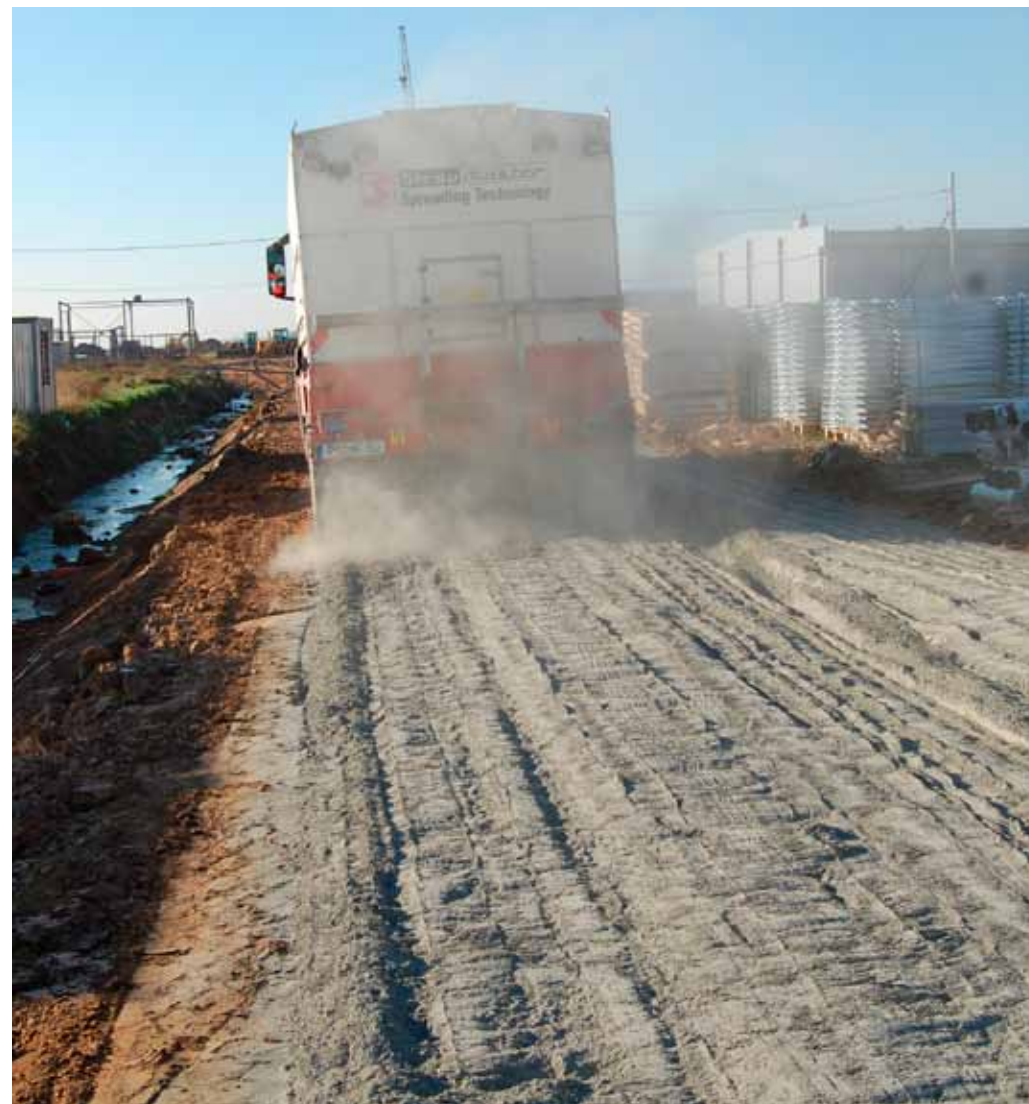
Распределение рассчитанного количества цемента по поверхности грунта
