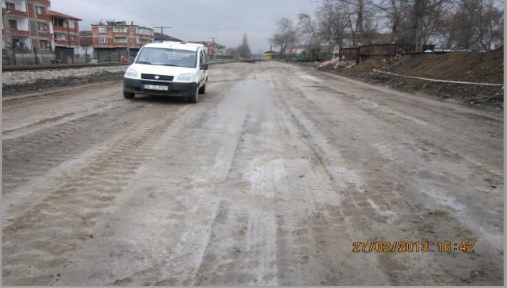
NovoCrete® imalatı sonrası zeminin görünümü - 27.02.2013
