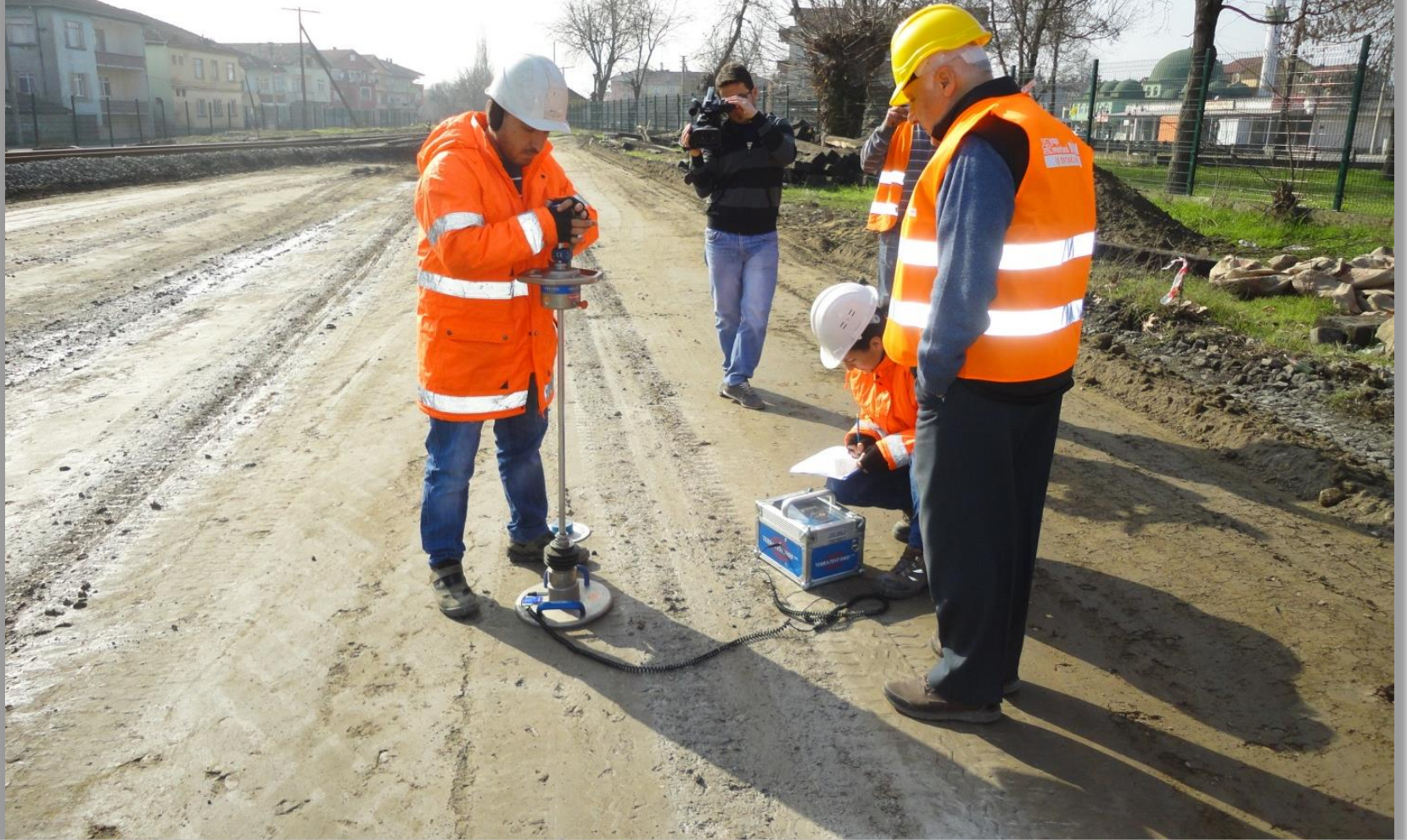
NovoCrete® imalatı sonrası Dinamik Plaka Yükleme Deneyi - 26.02.2013
