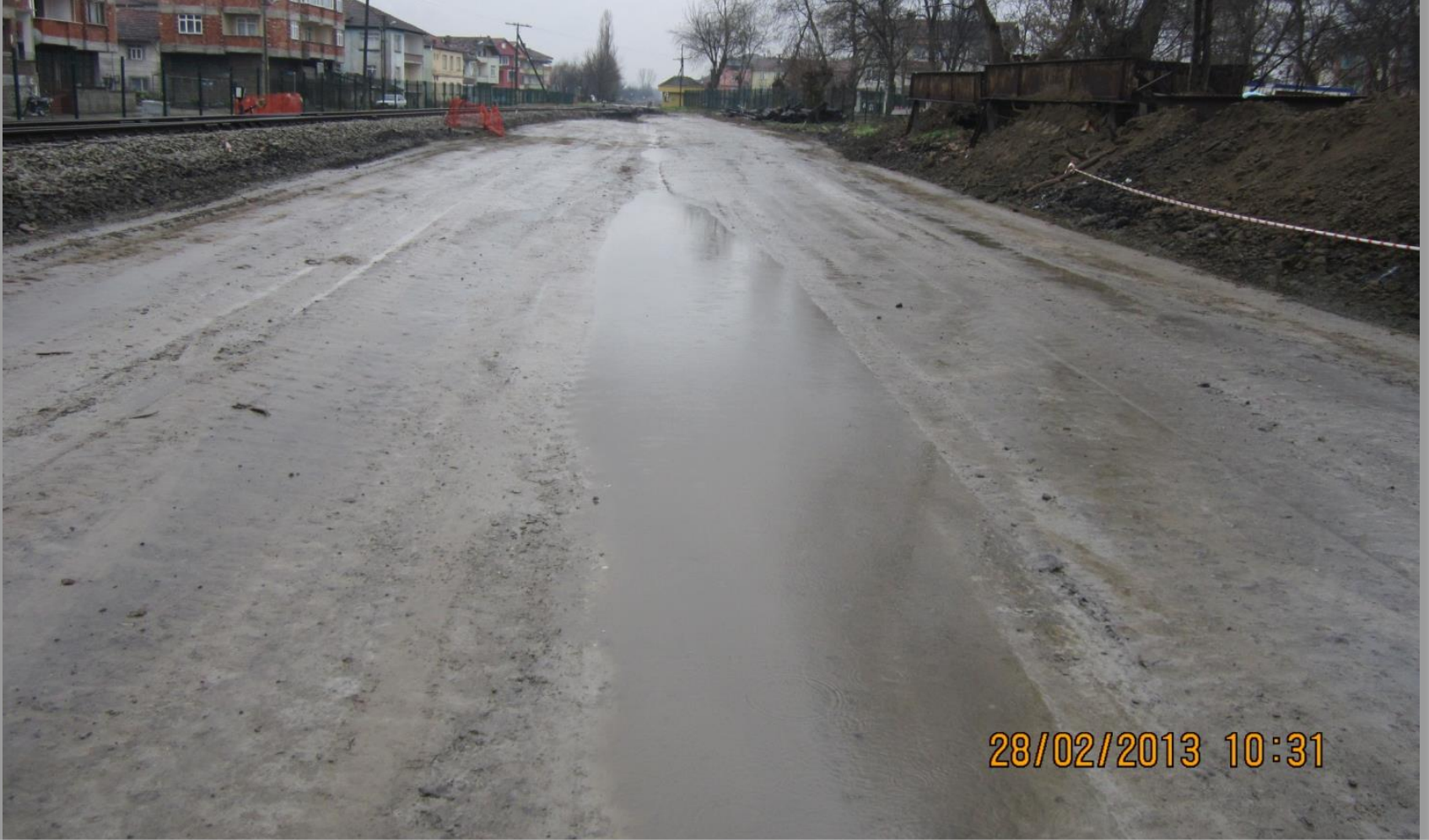
NovoCrete® imalat sonrası zeminin görünümü - 28.02.2013
