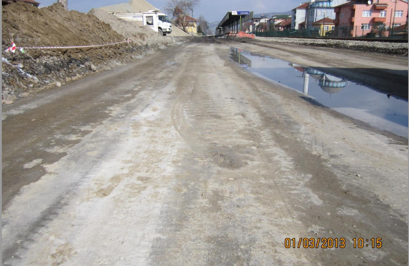
NovoCrete® imalat sonrası zeminin görünümü - 01.03.2013
