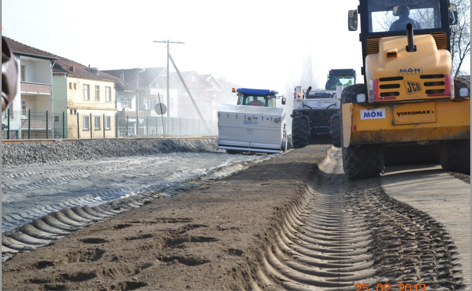
Dozajlı NovoCrete® Serimi, Frezeleme işlemi ve Silindir ile sıkıştırma
