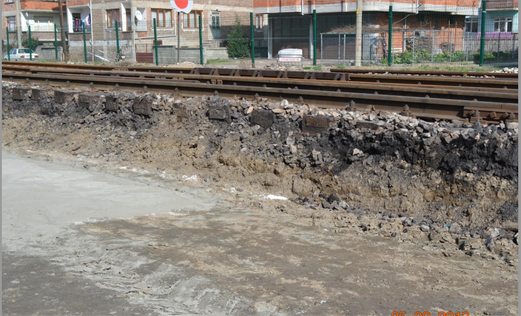
NovoCrete® imalat sonrası zeminin görünümü - 25.02.2013
